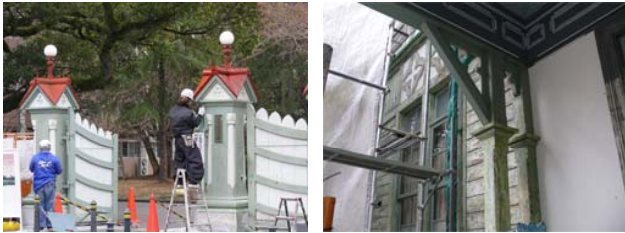
学内補修作業(奈良女子大学メールマガジンより抜粋)
