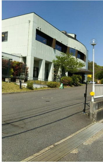
写真 3-3 B 施設外観
