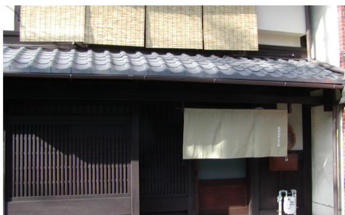
写真 5-3 H 施設 外観
