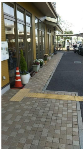
写真 5-3 G 施設玄関 (道路から中の様子が見える)
