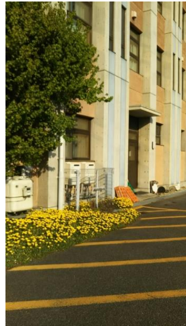
写真 4-5 外観 側面から
