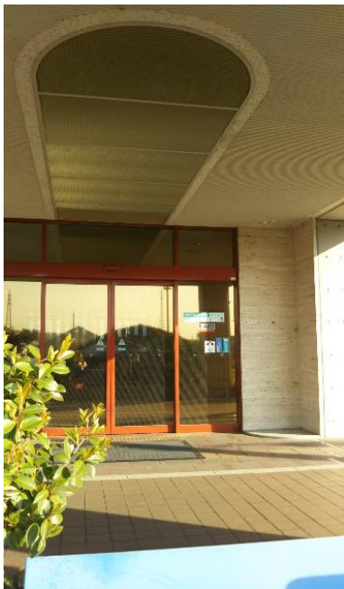
写真 4-4 D 施設 正面玄関
