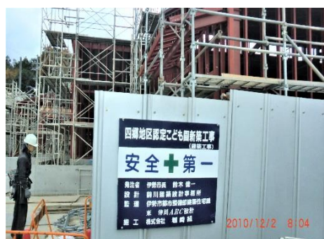
写真 2-8 あさま保育所の敷地と隣接の敷地に新築中
