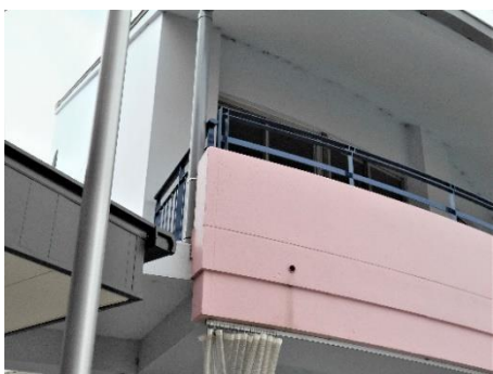
写真 2-31 右の幼稚園と新築した保育所の2階の隙間 園児が飛び越えていけそうな隙間（2016年7月15日筆者撮影）
