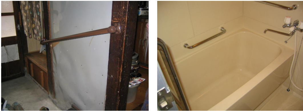
図 4-2 事例 No.13 玄関手すりと風呂のバリアフリー化
