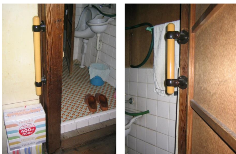
図 4-6 事例 No.4 便所手すり
